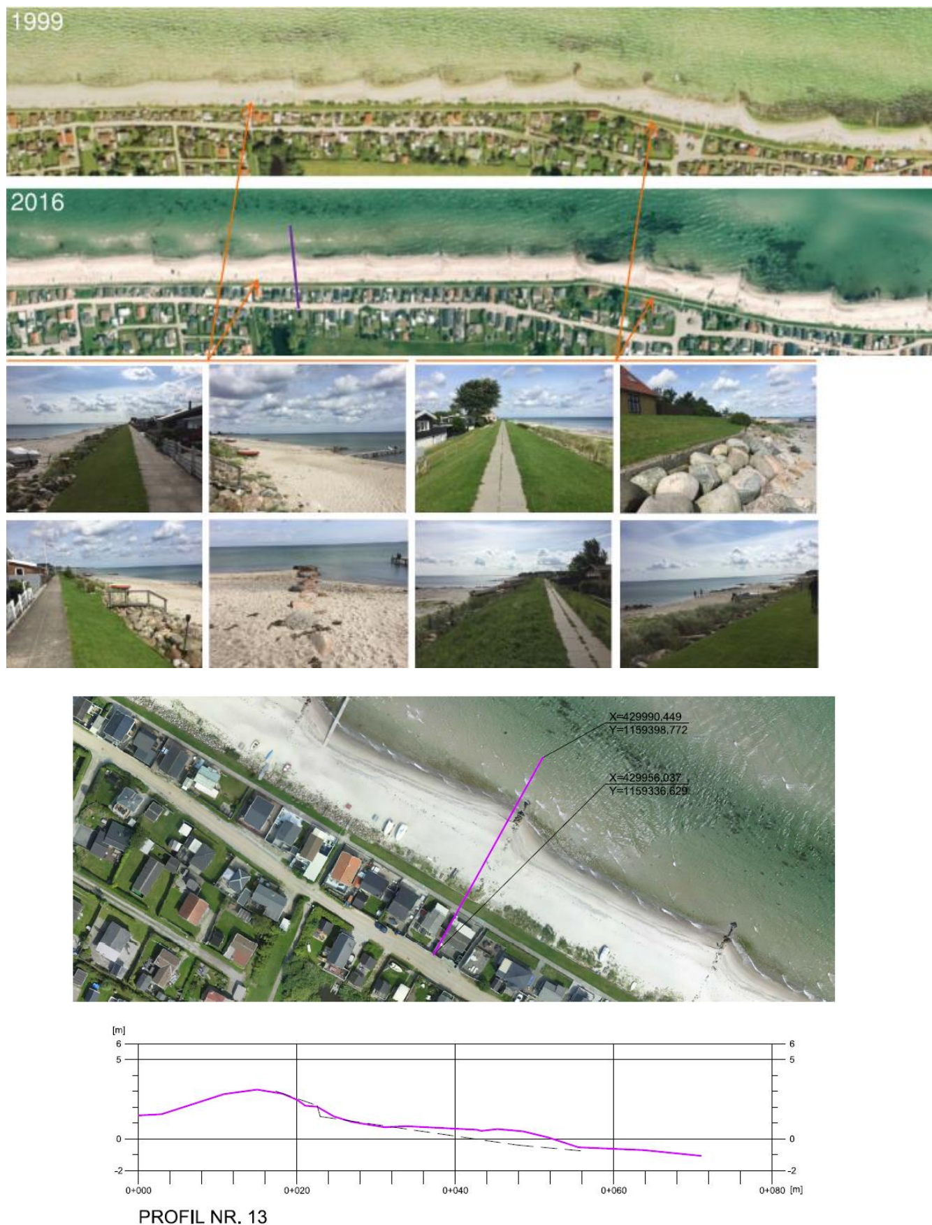
Figur 4-13 Hasmark mellemstræknings og østre dige. Strækning besøgt d. 7. august 2017. Profil 13 markeret på 2016-plan med lilla linje. Lilla og stipleet sort kurve på profil er opmåling fra hhv. 2017 og 1999.
