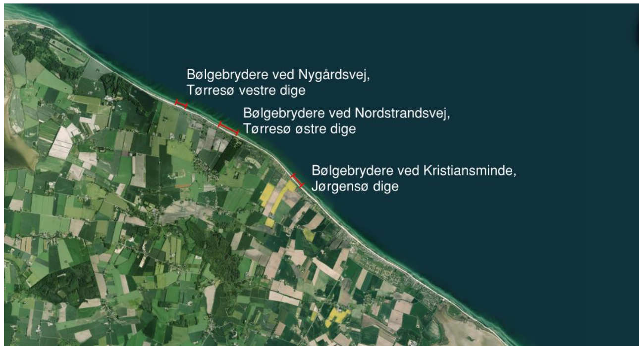
Figur 3-1 Oversigtsbillede over anlagte konstruktioner langs nordkysten.
