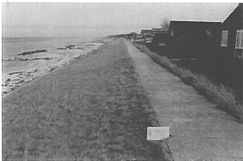
Foto 8: Diget langs Tørresø Strand. I billedets venstre side ses sandstrand med stenhøfder, bølgebrydere og skråningsbeskyttelse foran diget.
