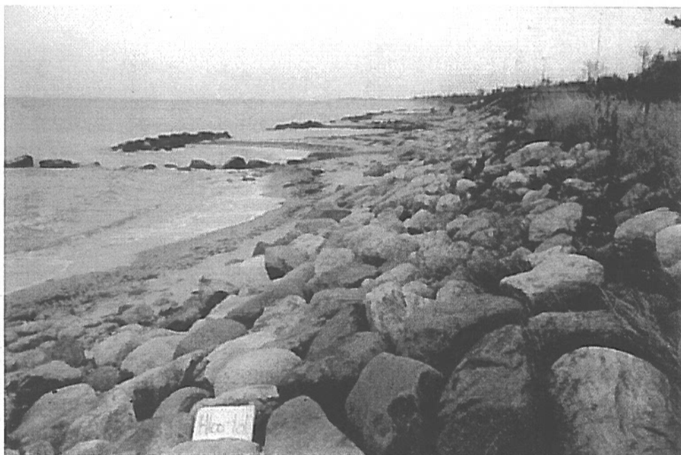
Foto 9: Smal sandstrand med stenhøfder, bølgebrydere og skråningsbeskyttelse ved Kristiansminde.
